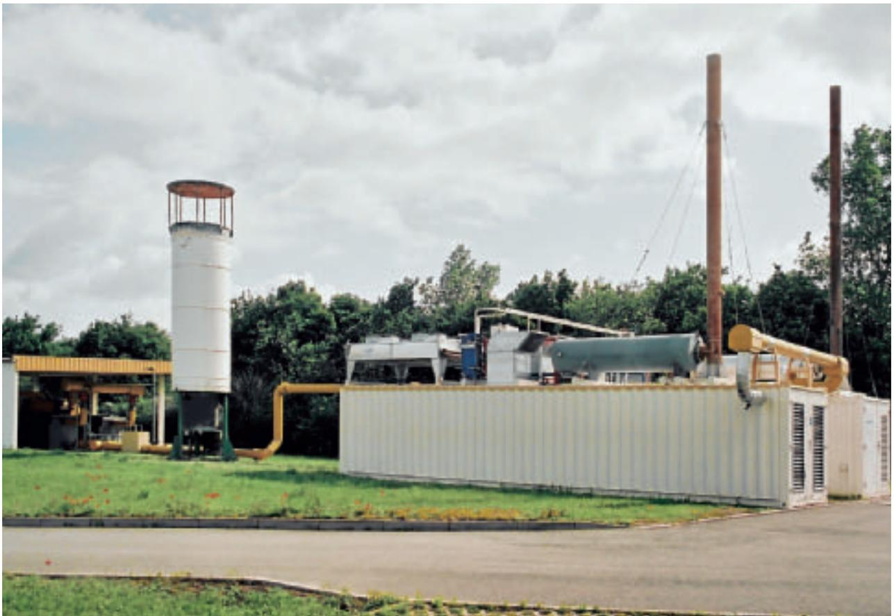
Abb. 21: Deponiegasverwertung im Blockheizkraftwerk der Deponie Schwerborn
