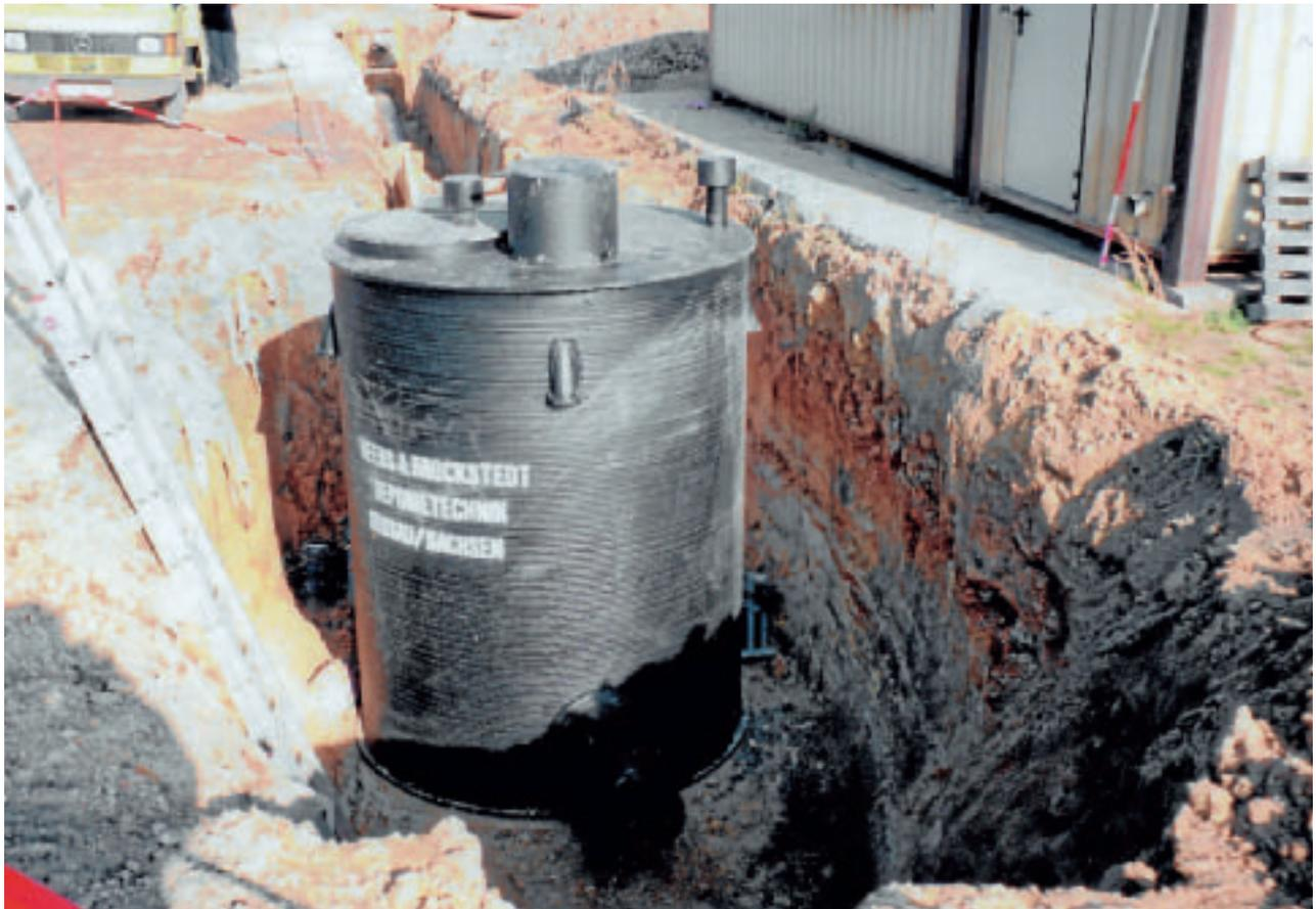
Abb. 18: Errichtung Sickerwassersammelschacht mit -transportleitung an der Deponie Wiewärthe
