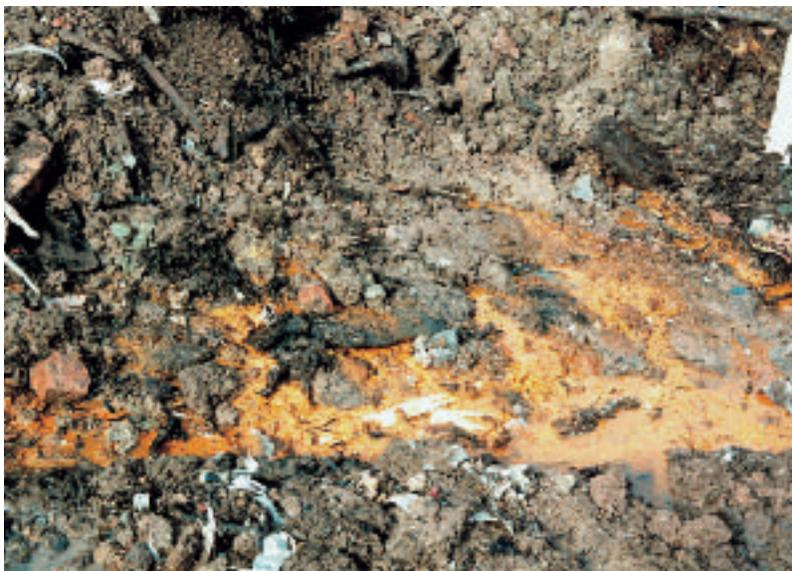
Abb. 3: Sickerwasseraustritte an der Deponie Gehren
