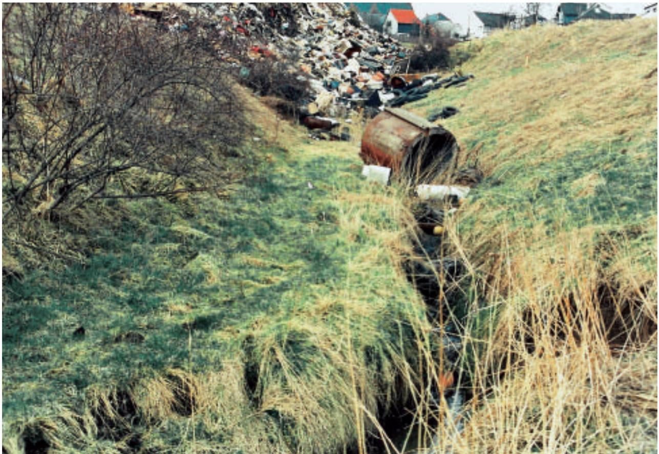
Abb. 8: Überkipfung eines Baches an der Deponie Herschdorf
