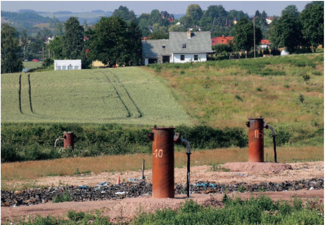
Abb. 20: Gasbrunnen zur Erfassung von Deponiegas der Deponie Wiewärthe
