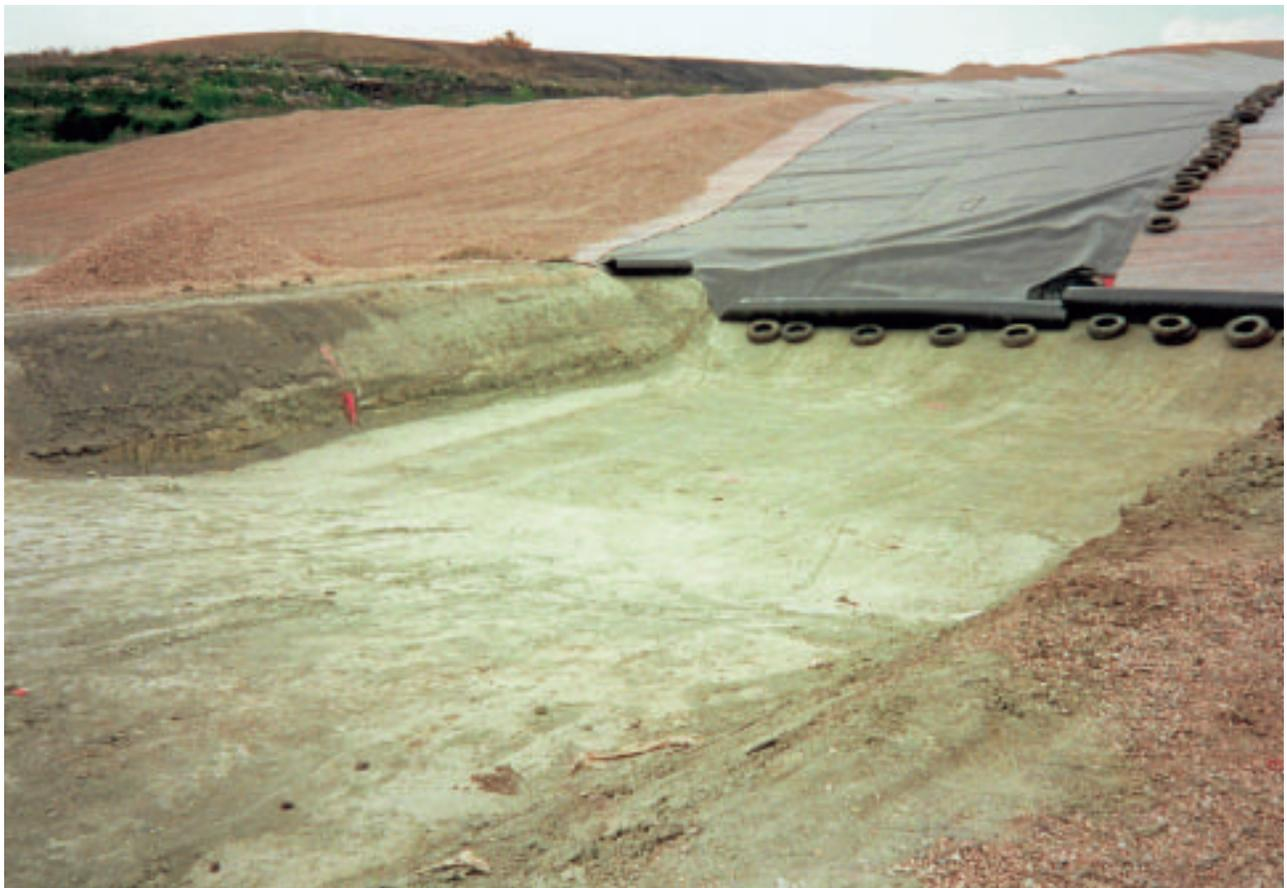
**Abb. 15:** Bau der Basisabdichtung im Neuteil der Deponie Rehestädt
