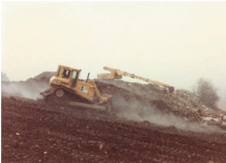
**Abb. 34:** Umprofilierung des Müllkörpers der Deponie Schmiedefeld
