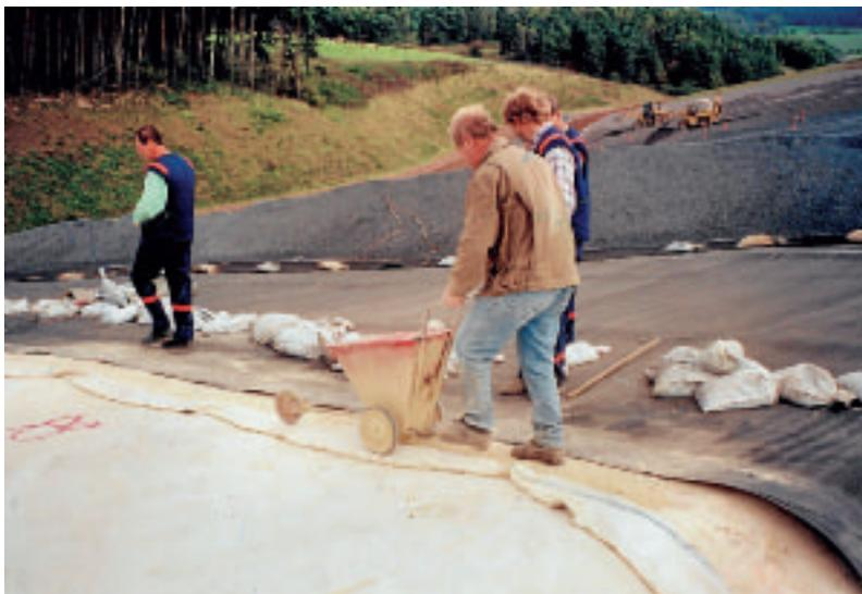
**Abb. 36:** Herstellung der Oberflächenabdichtung (Betonitmatte + KDB) auf Deponiealtkörper der Deponie Eichental
