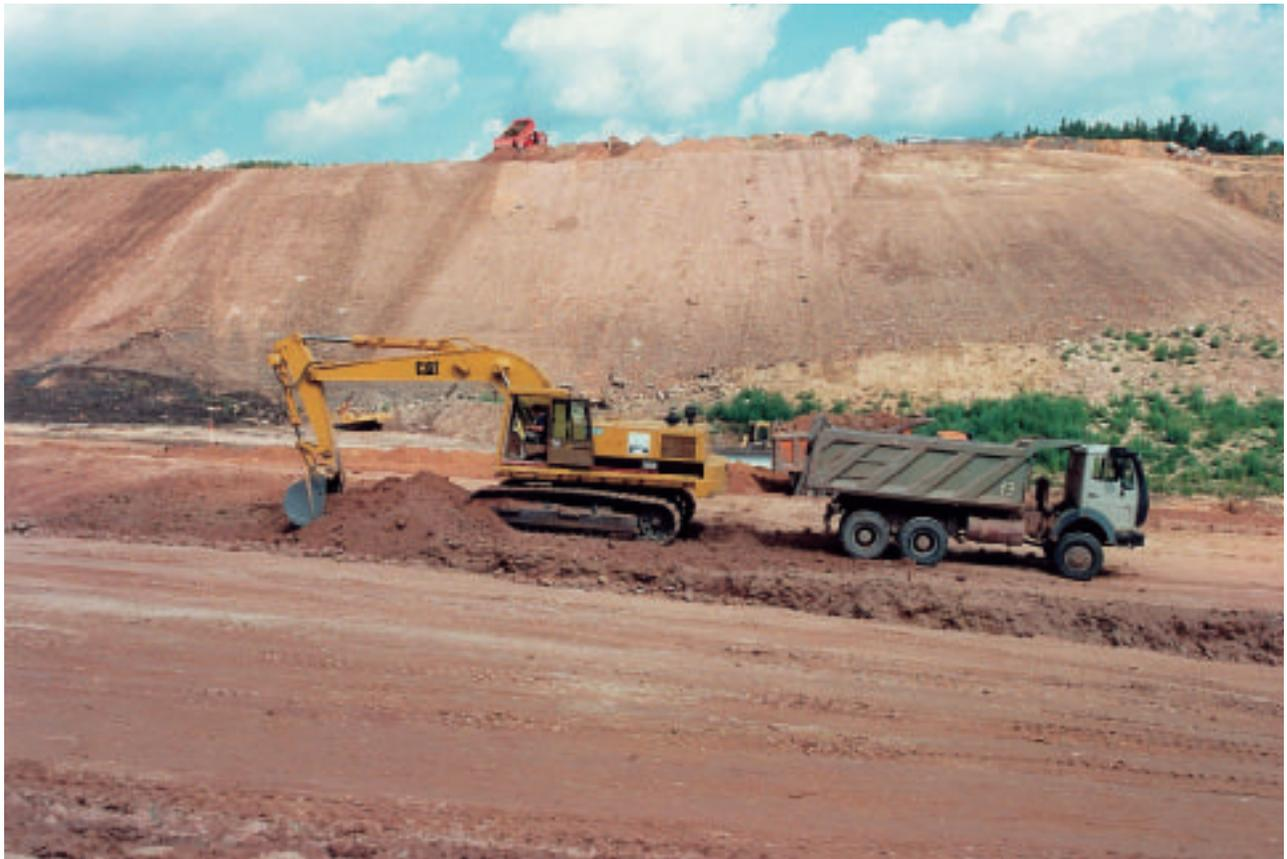
**Abb. 14:** Herstellung der Auflager für die Zwischenabdichtung zum Altteil und zur Basisabdichtung des Erweiterungsabschnittes der Deponie Wolfsberg
