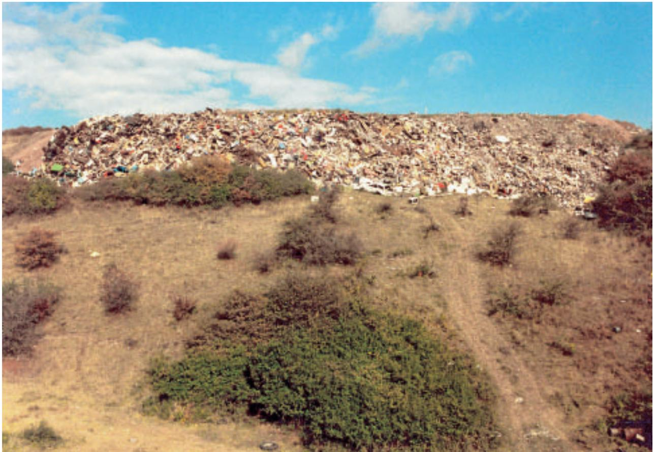
**Abb. 39:** Altdeponie Geschwenda mit bis 20 m hohen, nahezu senkrechten Flanken
