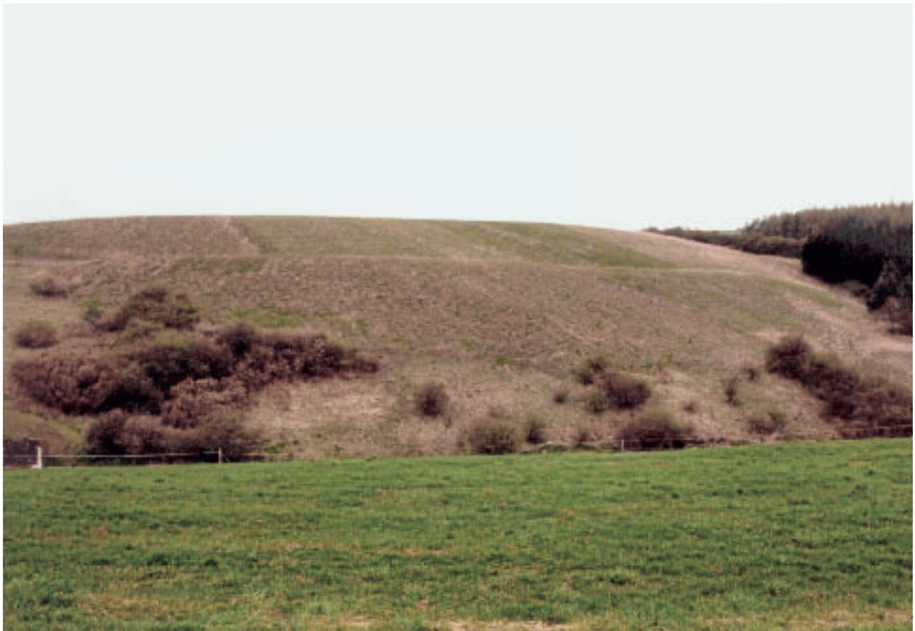
**Abb. 40:** Altdeponie Geschwenda nach Oberflächenabdichtung und Rekultivierung
